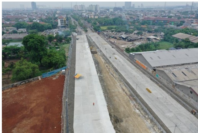
Gambar 8 Jalan Tembus Pulogadung - Kelapa Gading Tahun 2023 Sumber: Dokumentasi Dinas Bina Marga
