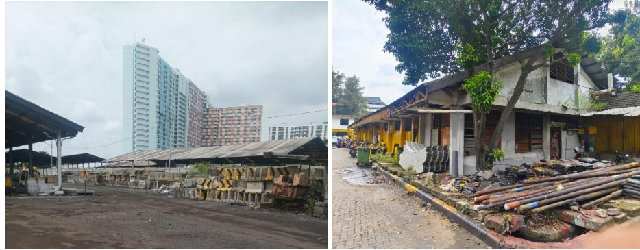
Gambar 5. Gudang material Dinas Bina Marga Provinsi DKI Jakarta Sumber: Dokumentasi Dinas Bina Marga
